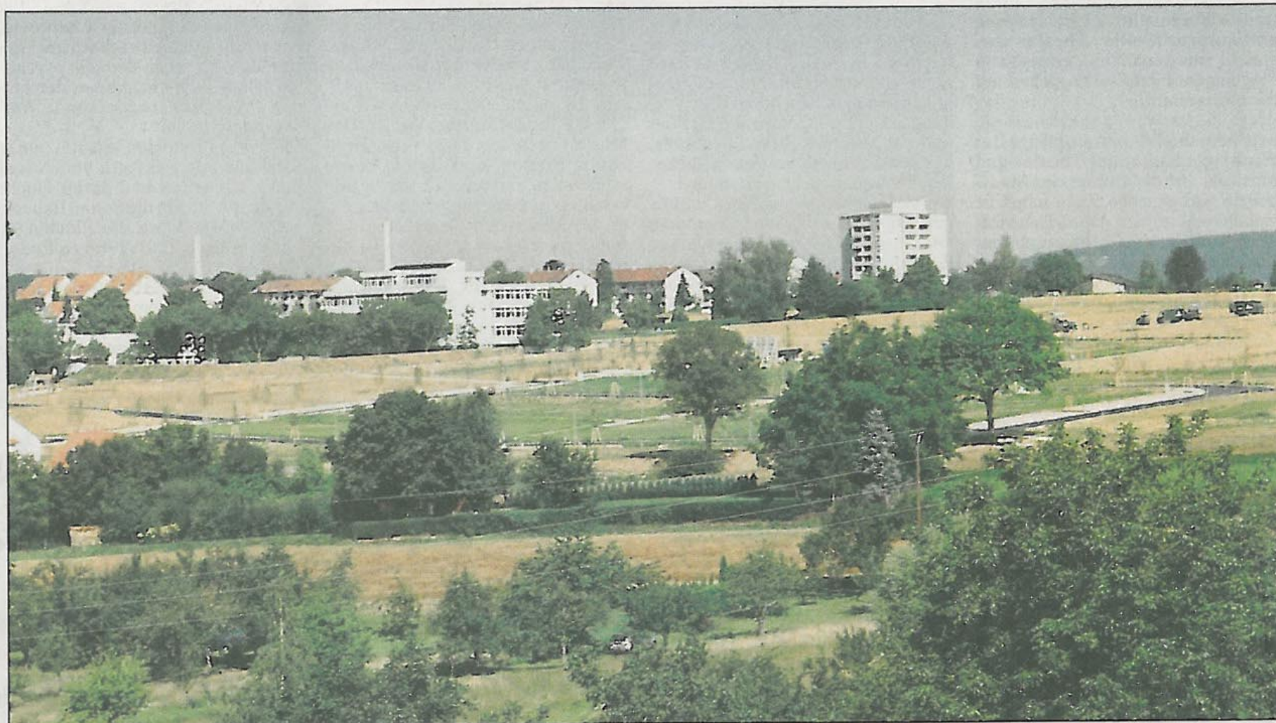
Im Wernauer Neubaugebiet Adlerstraße Ost II müssen sich Bauherren darum kümmern, wie sie trockene Keller bekommen. Denn das Grundwasser steht dort hoch. Unterhalb des 4,9 Hektar großen Areals sammelt sich Wasser, das über einen Graben entlang der Weidachgasse abgeleitet wird. Foto: e
